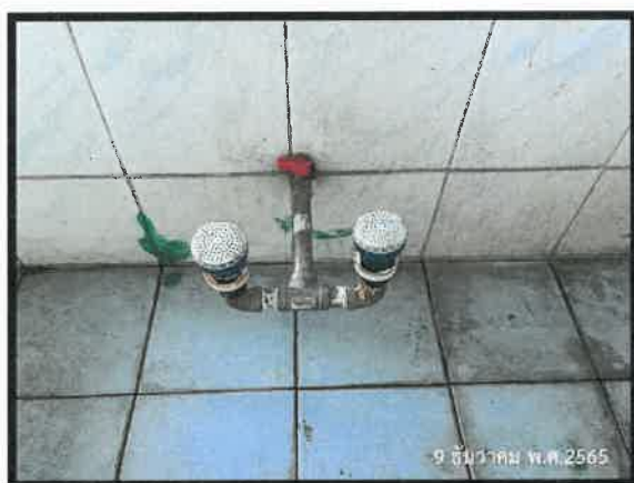
รูปที่ 3.1-35 อุปกรณ์ล้างตา ฝักบัวฉุกเฉิน
