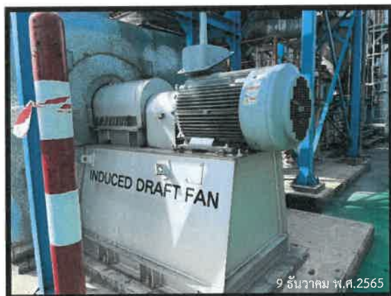
รูปที่ 3.1-3 แผ่นรองกันสะเทือนหรือมีฝาปิดครอบ เพื่อลดแรงสั่นสะเทือน
