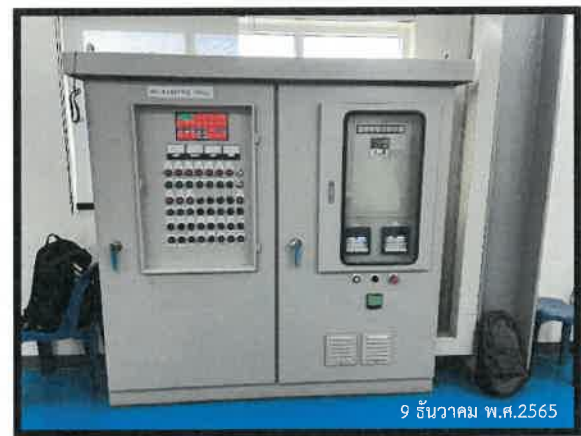
รูปที่ 3.1-29 ตู้คอนโทรลระบบไฟฟ้า
