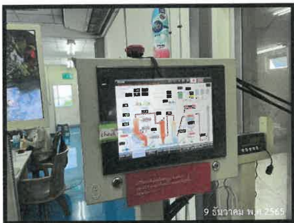
รูปที่ 3.1-2 ตู้ควบคุมอุณหภูมิในการเผา 800-1,200 องศาเซลเซียส
