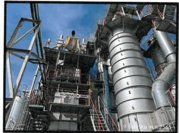
รูปที่ 3.1-5 รูปควบคุมอากาศเสียในอาคารเผาไหม้ ได้แก่ Cyclone Cooling Tower และ Bag Filter
