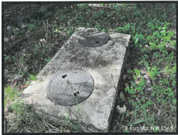
รูปที่ 3.1-10 รูปบ่อเกรอะ (Septic tank) และบ่อน้ำทิ้ง
