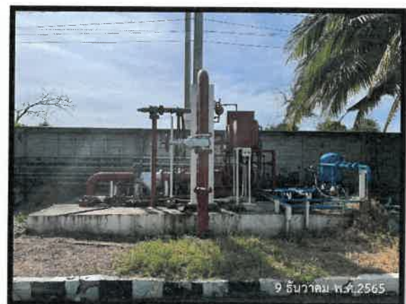
รูปที่ 3.1-42 Fire Pump และ Jockey Pump ภายในพื้นที่โครงการ
