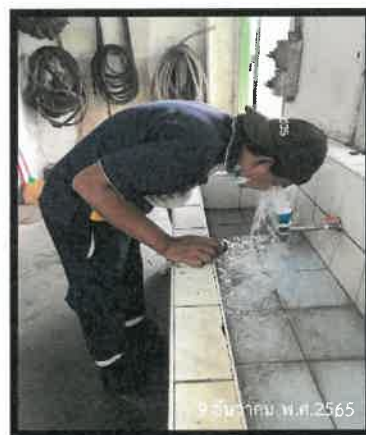
รูปที่ 3.1-35 อุปกรณ์ล้างตา ฝักบัวฉุกเฉิน
